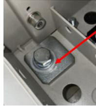
アンカー用ボルト(ナット)、ワッシャ類も穴のセンターで施工
