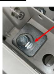
アンカー用ボルト(ナット)、ワッシャ類も穴のセンターで施工
